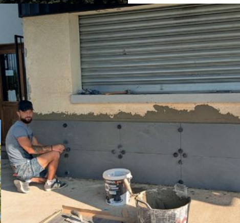
▲ Travaux Espace Gaby-Fornoni
