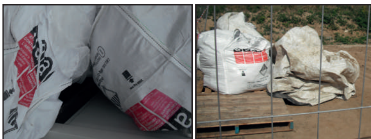
Big bag de déchets amiantés
