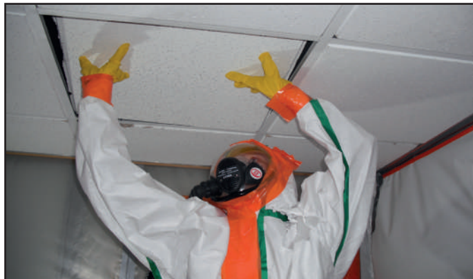
Déplacement de faux-plafond amianté pour intervention
