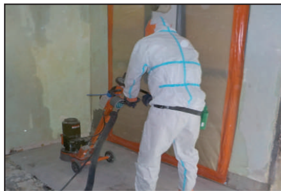
Retrait de colle amiantée par ponçage
