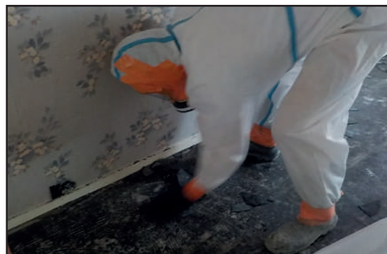
Ramassage de dalles amiantées après travaux
